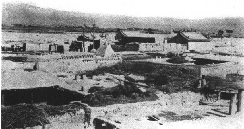
| ②19建有城墙的昌马村子内部 |
