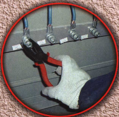
4. 用钳子扳旋螺母，紧固螺母。
