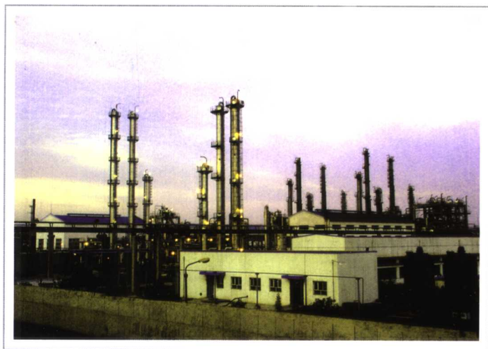
义马气化厂生产区
