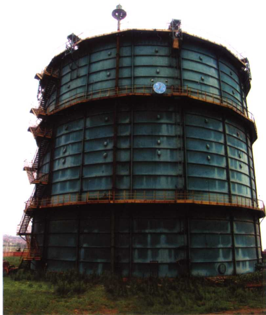
城市民用煤气储气罐
