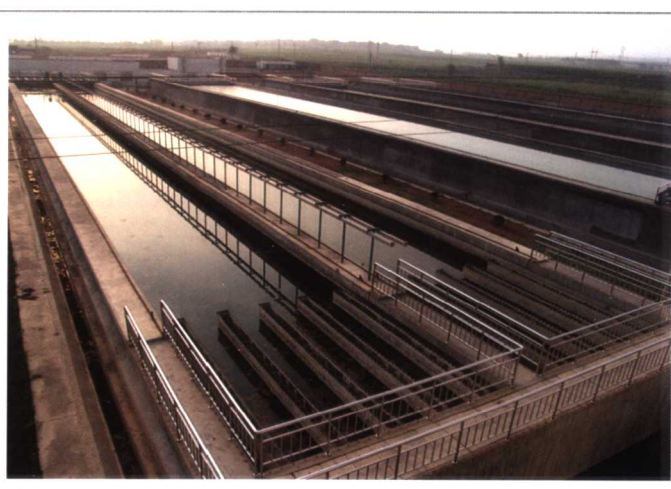
城市供水工程——13万吨水厂
