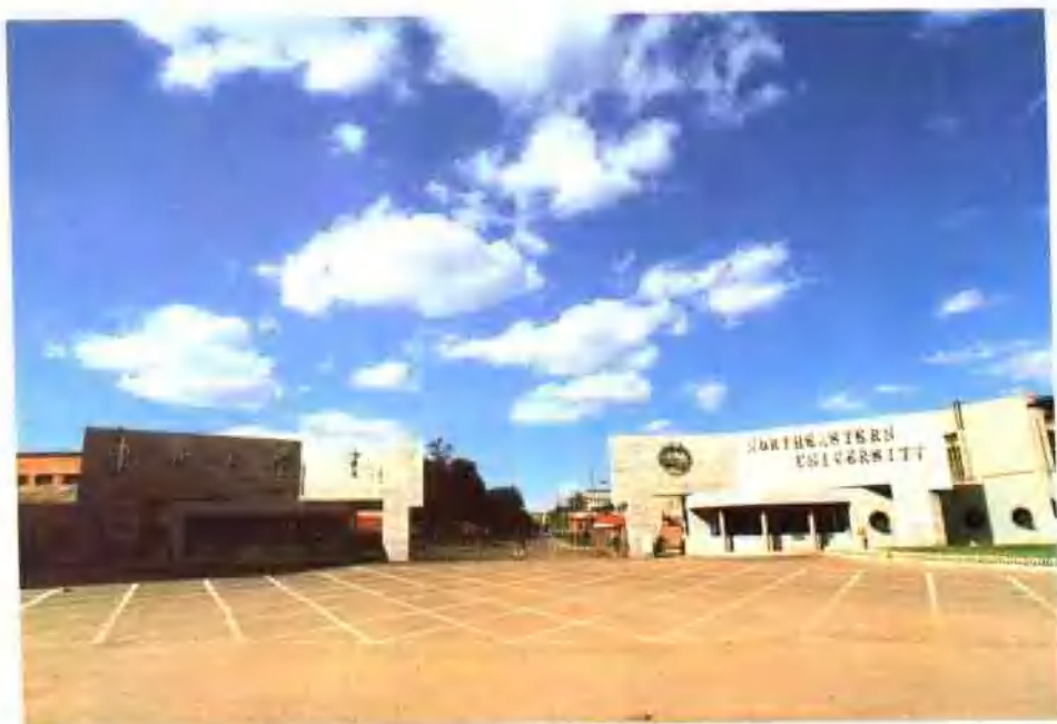
6月12日,东北大学南大门正式竣工并投入使用
