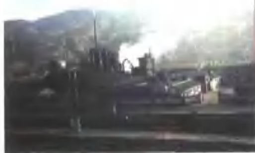
陇西县化工厂厂貌
