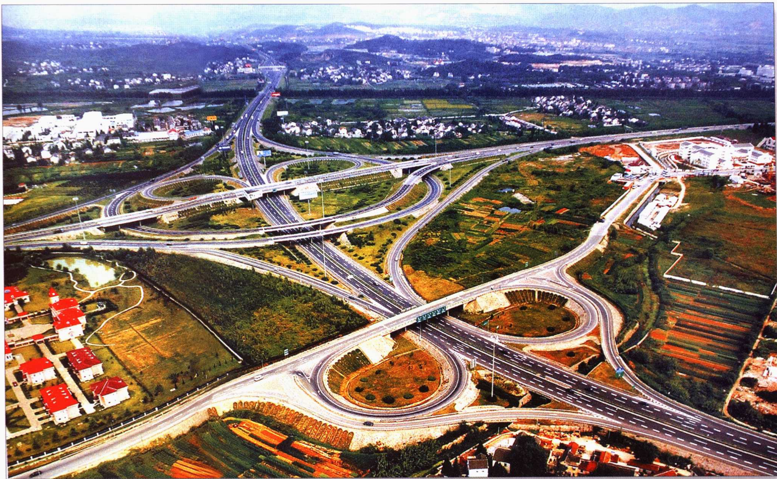
马群高速公路立交桥
