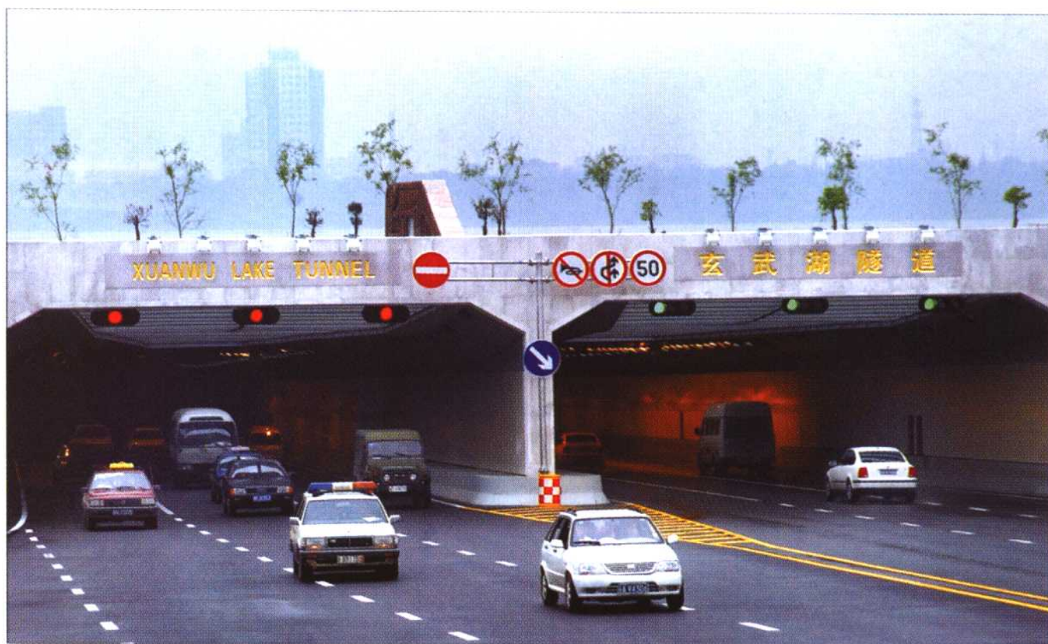
玄武湖隧道新庄出入口
