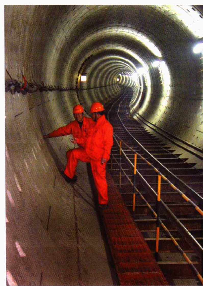
地铁一号线总投资近85亿元。自2000年12月开工以来已完成工程投资量的49%，2005年正式营运
