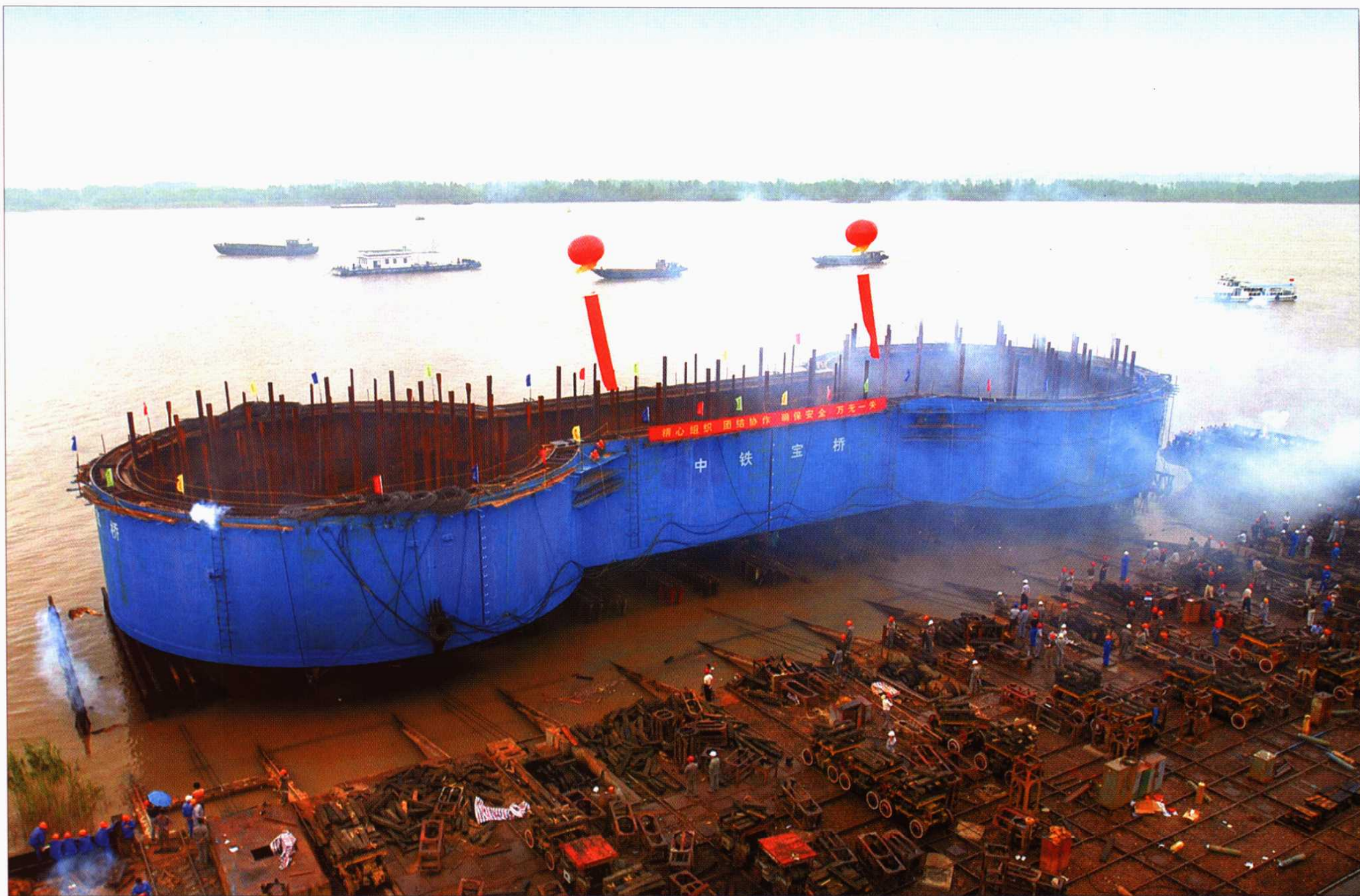
南京长江三桥主塔基础钢套箱成功下水
