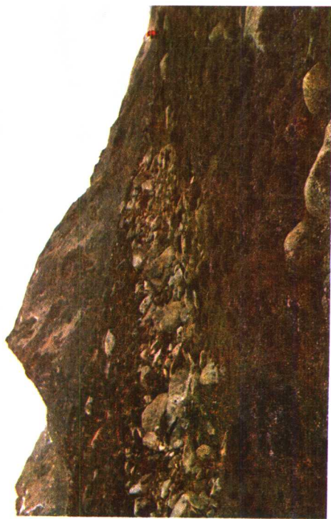
照片3 康定斯丁错北东冰碛层中的断坎及1955年地震裂缝，向南西倾斜，高0.6—1.0m。镜向南东。
