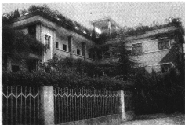
图9 姜山头公路管理站
