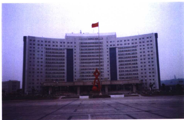
江阴市政府大楼
