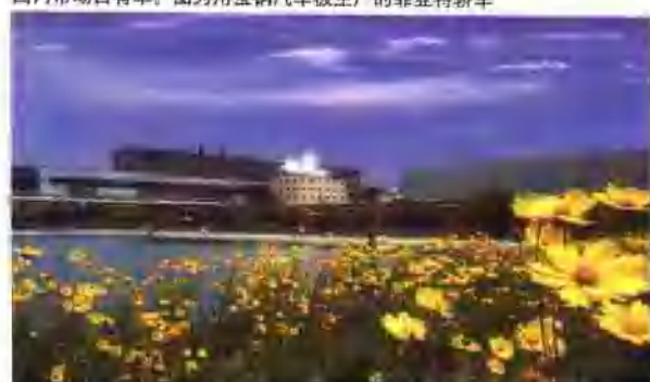
宝钢在国内冶金行业中，率先通过ISO14001环境管理体系认证，对用户、对社会、对生态的承诺和关爱体现在宝钢生产作业流水线上。图为宝钢的水处理设施。
