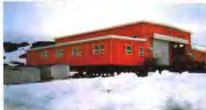
宝钢生产的彩色涂层钢板，广泛用于建造度假村、移动式宾馆、国家级大型粮仓等。图为用宝钢氟碳彩色钢板建造的中国南极长城站发电楼。
