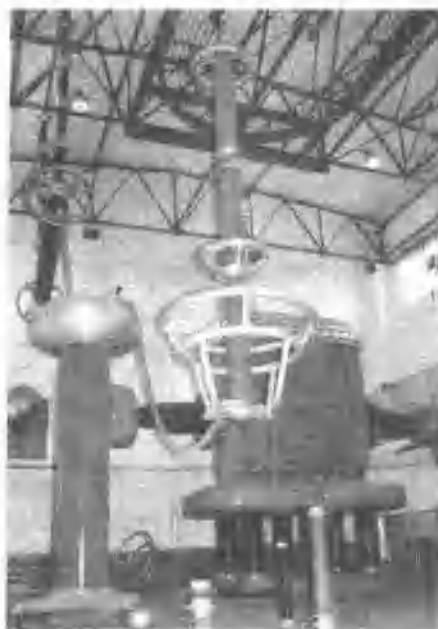
图 1-7 在实验室试验中的具有复合外套的 500kV 线路保护用金属氧化物避雷器 (照片中央悬吊着的、带有均压环的、由 3 个元件串接成的)
