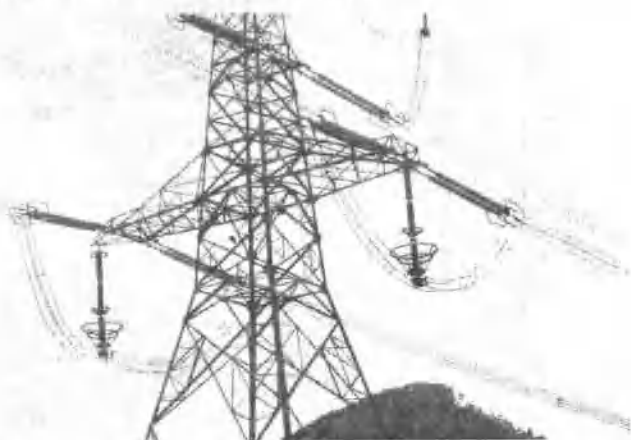
图 1-8 在线路中运行的 500kV 线路保护用复合外套金属氧化物避雷器 （图片中悬吊着的 2 个元件）
