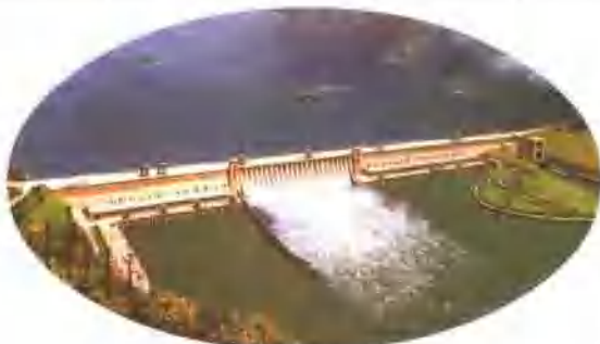
建设中的三峡水利枢纽。
