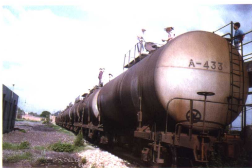
油罐槽车直通库区
