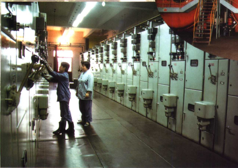
注重安全生产 配电工人正在作业中
