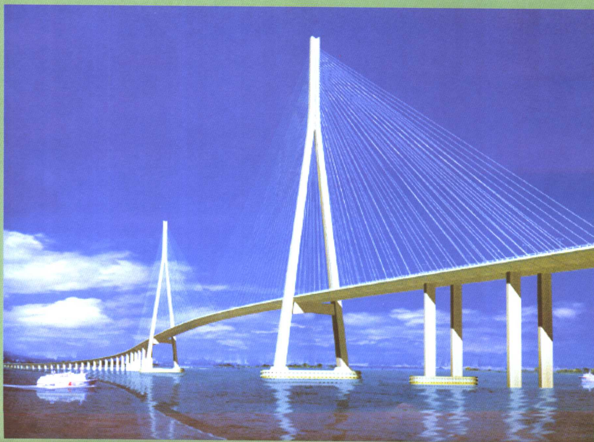
建设中的世界第一斜拉桥——苏通大桥效果图
