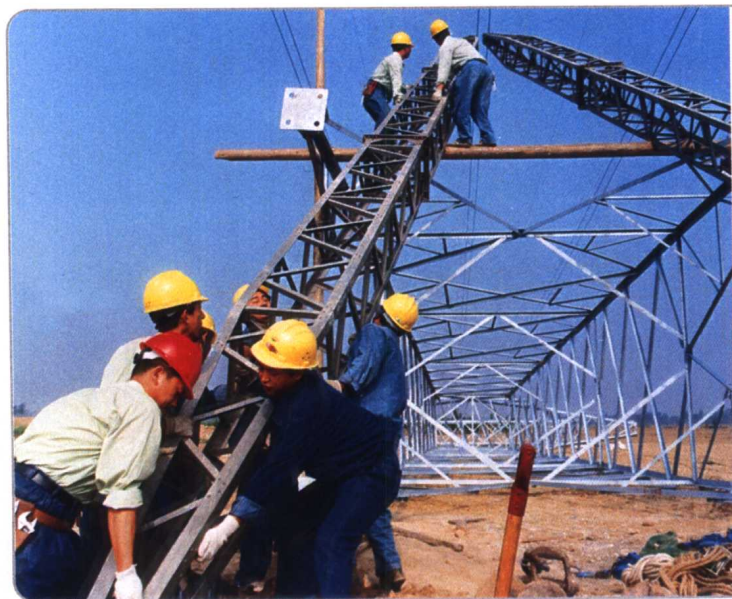
220千伏新洪线升高工程施工现场
