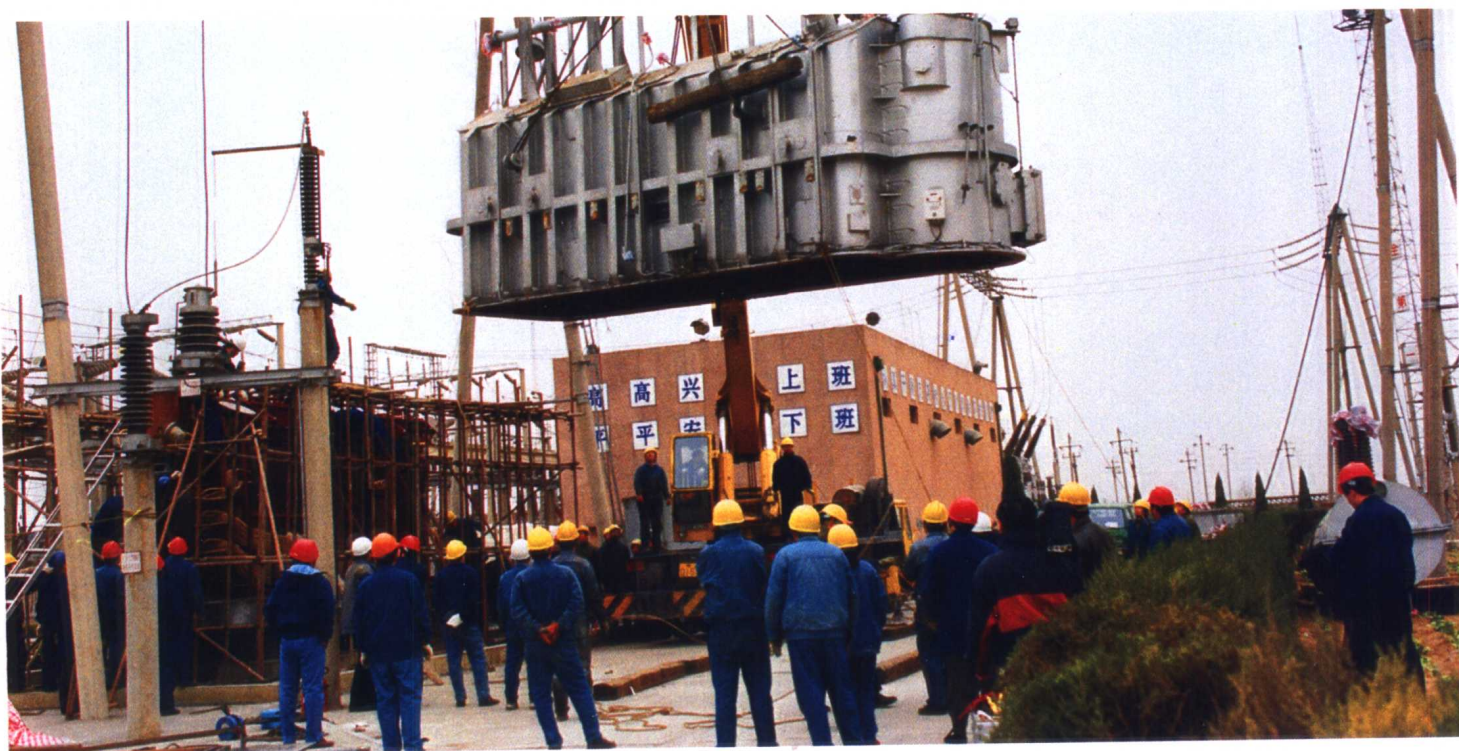
2001年2月220千伏古固寨变电站主变大修
