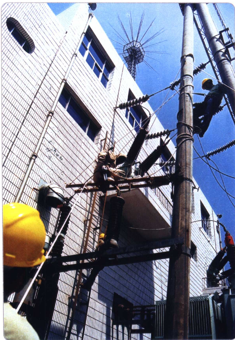
采用新技术实施带电作业
