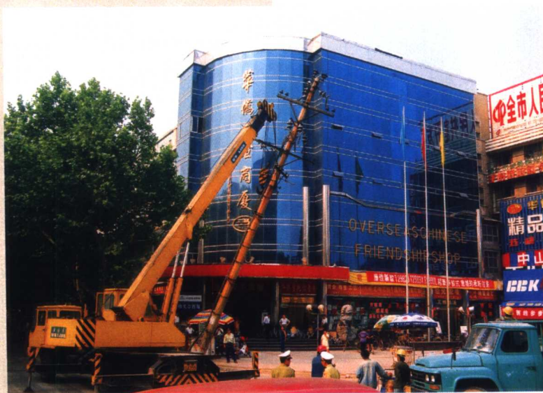
城网改造施工现场
