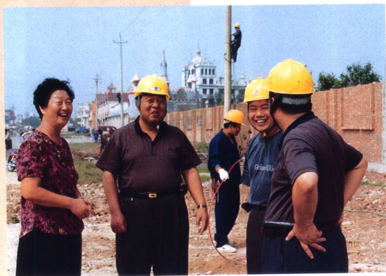
农网改造施工现场
