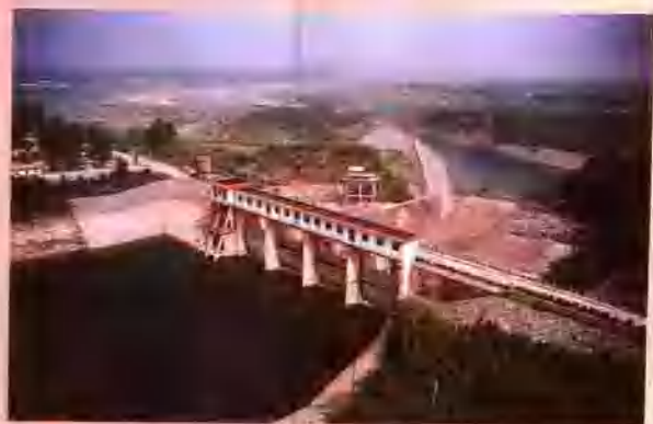
水库主溢洪道
