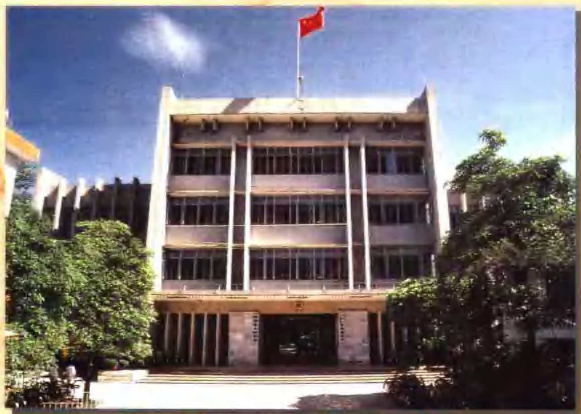
在原揭阳县人民委员会旧址改建的揭阳县人民政府(摄于1990年)
