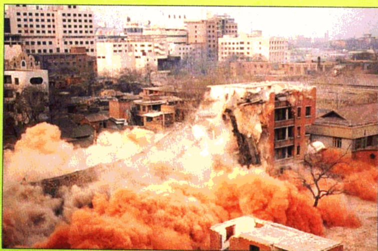
「四桥一路」工地拆迁爆破现场
