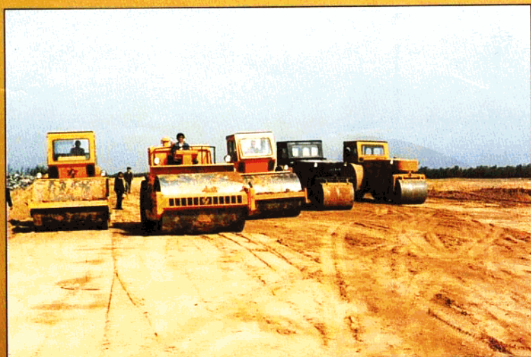
● 国道30高速公路路基施工中
