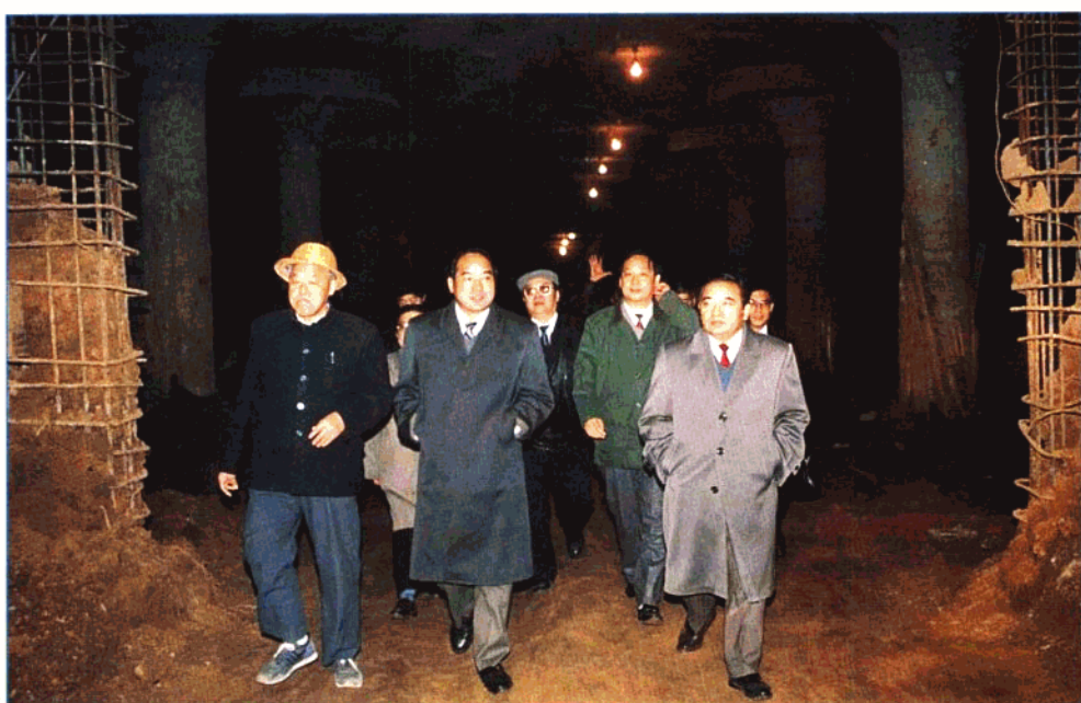
● 副省长张洪华、李志斌视察郑州火车站广场地下工程。
