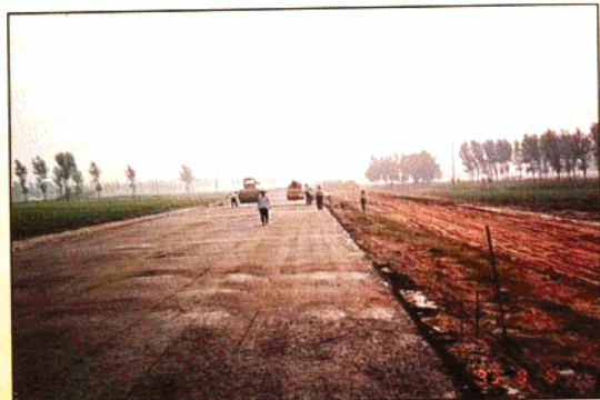
● 碾压混凝土施工中
