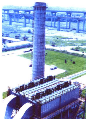
用于芜湖朱家桥70万吨粉磨系统 45万 \text{m}^3/\text{h} 风量的气箱脉冲袋收尘器
