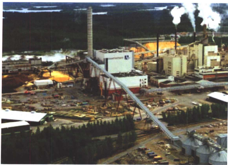
图4 Alholmen Kraft生物质能热电联产电厂(芬兰, 240MWe)
