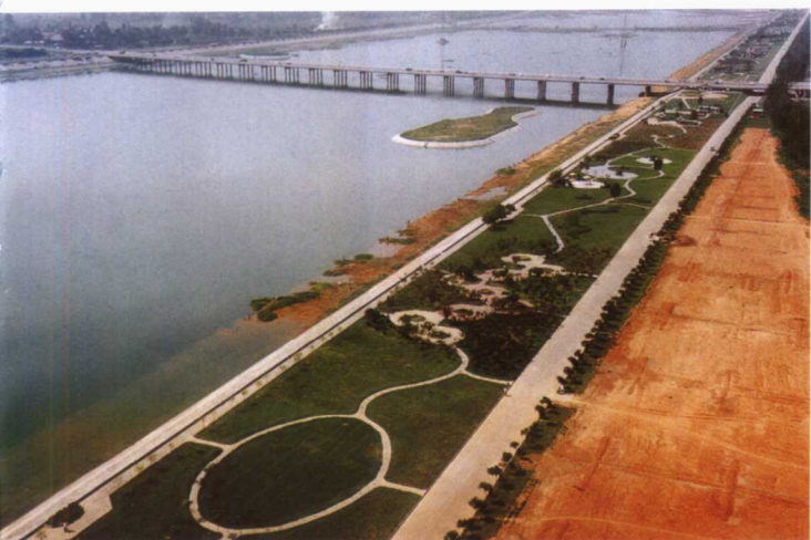
上阳宫水面工程
