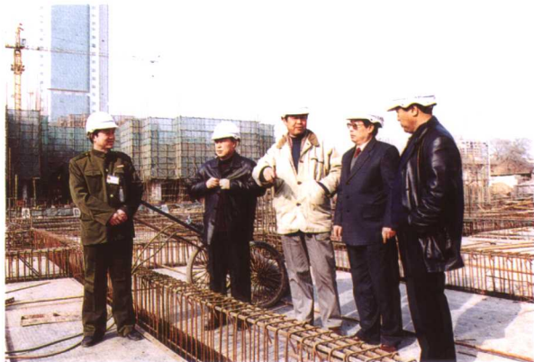
市人防办主任马旺信(右二)带领有关人员深入工地检查人防工程施工质量
