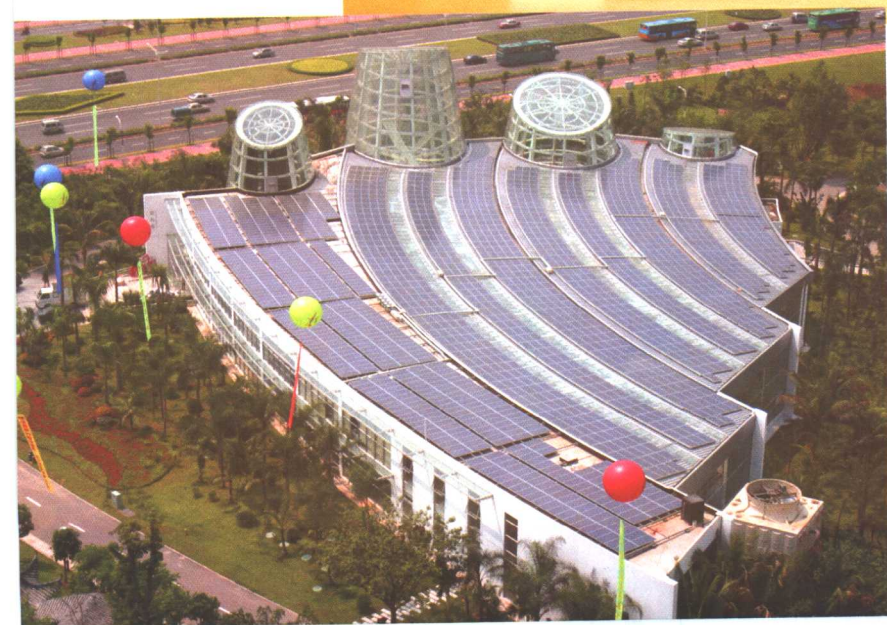
◀ 深圳国际园林花卉博览园装备了 BP 太阳能光伏并网发电系统, 发电总装机容量达到 1 兆瓦, 是世界上为数不多的兆瓦级大型太阳能光伏发电系统之一。
