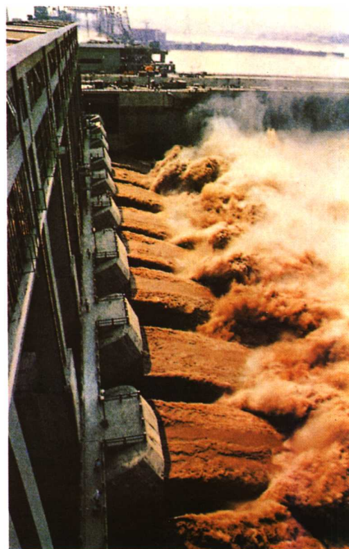
中国工商银行贷款支持的葛洲坝水利工程
