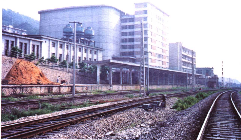
三明市肉联一厂冷库及铁路专用线
