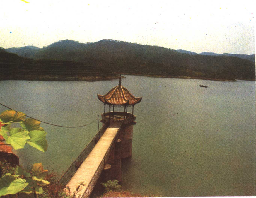
◀ ▼ 新店水库和沙 河子渡槽
