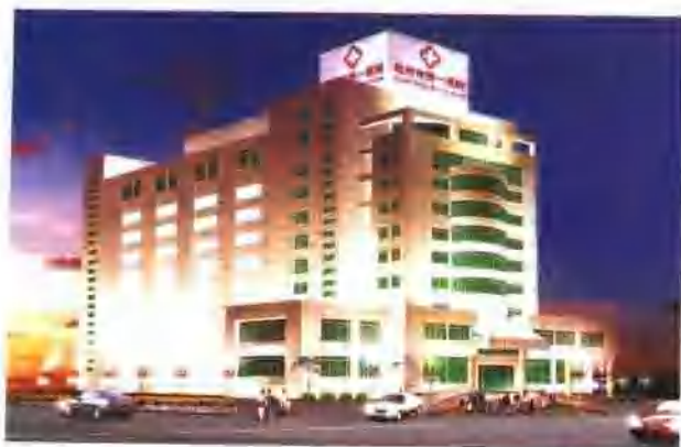
泉州市第一医院病房大楼
