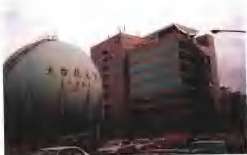
大台北瓦斯公司儲氣槽(1990年)
