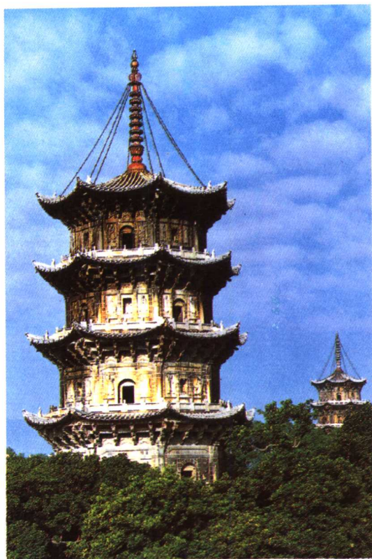
大开元寺东西两塔。
