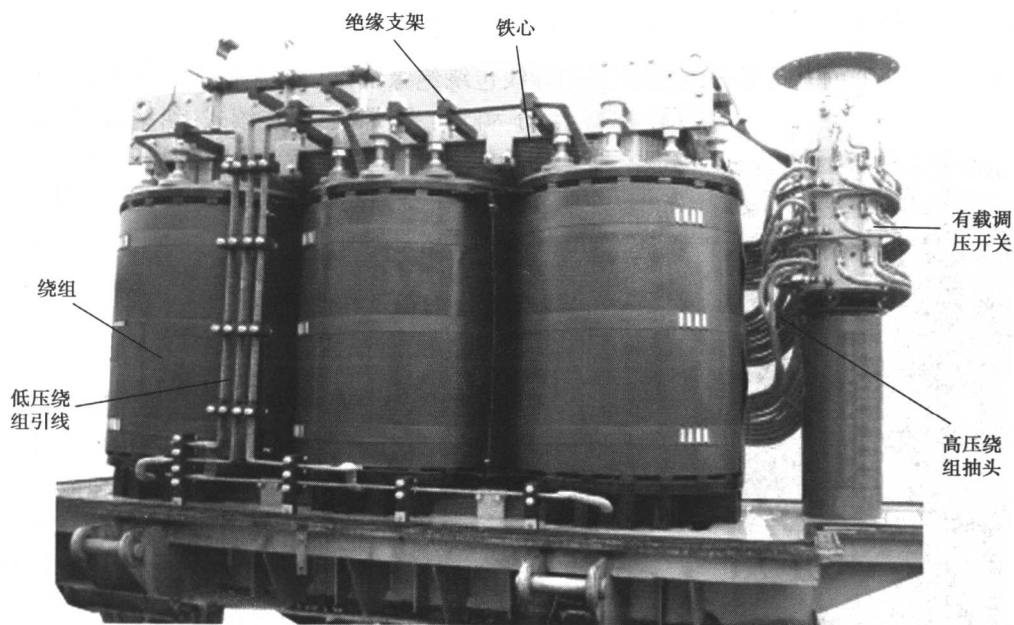
图 1.3 三相油浸式电力变压器的器身
