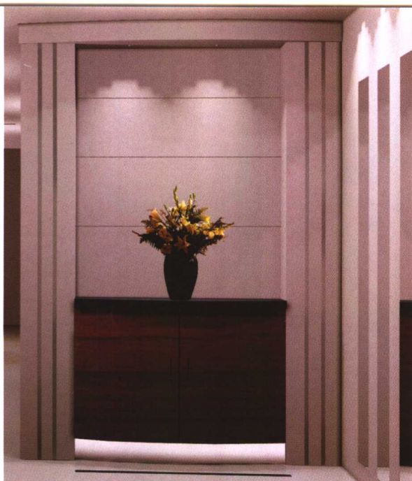
▲ 唐珂 采用石膏板抽缝，两侧镶嵌有白钢条，体现出现代大方之美。
