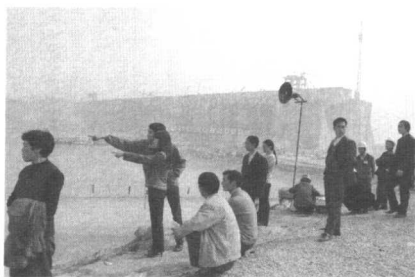
在建中的三峡大坝（摄于2002年11月6日）
