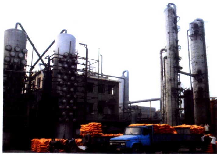
骏马化工集团股份有限公司西平分厂
