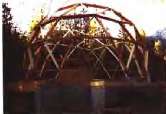
图 1-35 搭建球形骨架
