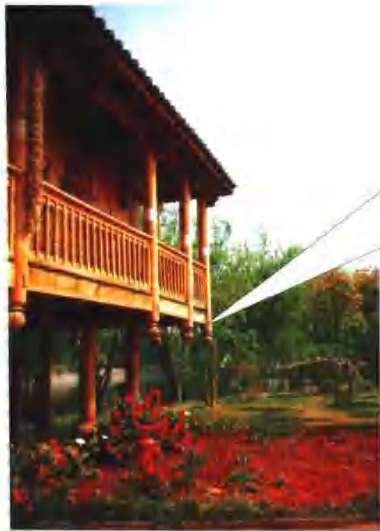
图 1-1 广西民居(吊脚楼)(1)
