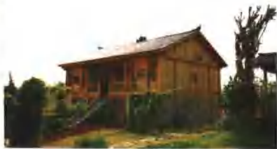
图 1-3 广西民居(吊脚楼)(3)
