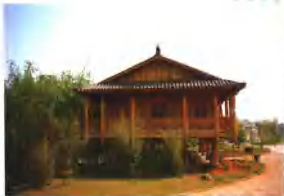
图 1-2 广西民居(吊脚楼)(2)
