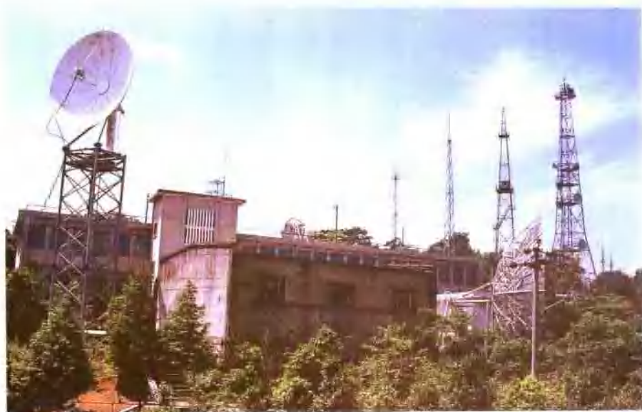
1981年投运的重庆电力系统第一个微波通信站——北碚供电局缙云山微波通信站
