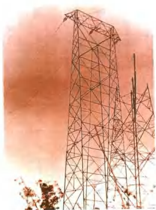
1952年重庆市第一条35千伏线路——大溪沟至弹子石的过江铁塔
