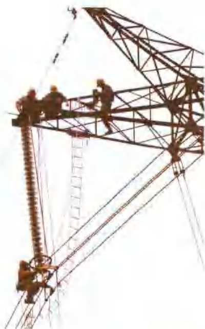
2000年500千伏线路检修
