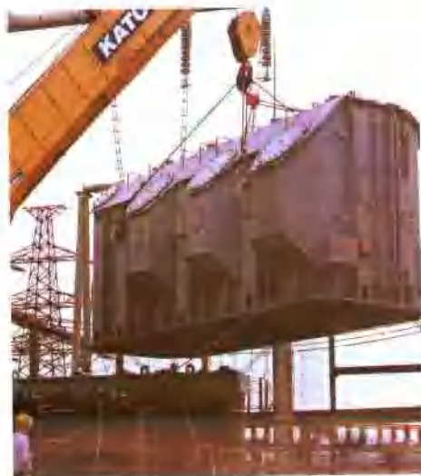
1999年江津供电局220千伏黄 荆堡站变压器大修
