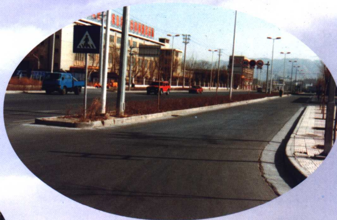
西宁市城建局互助路道路与排水扩建工程
