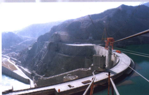
黄河上游的明珠——李家峡水电站
