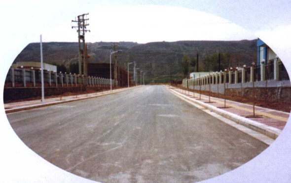
西宁经济技术开发区七号道路工程
