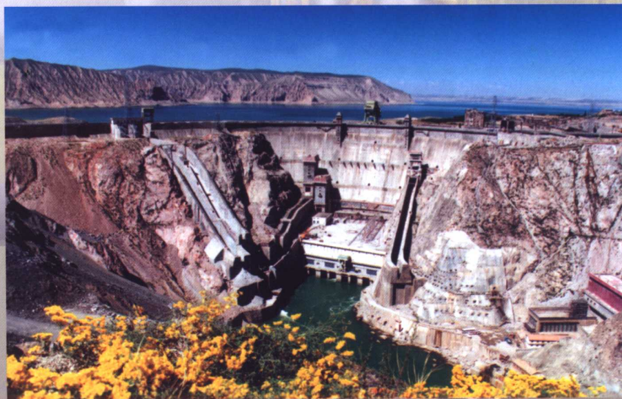
万里黄河第一坝——龙羊峡水电站
