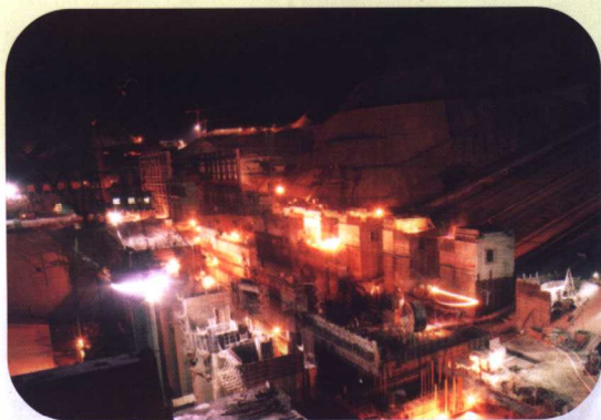
公伯峡水电站施工夜景
