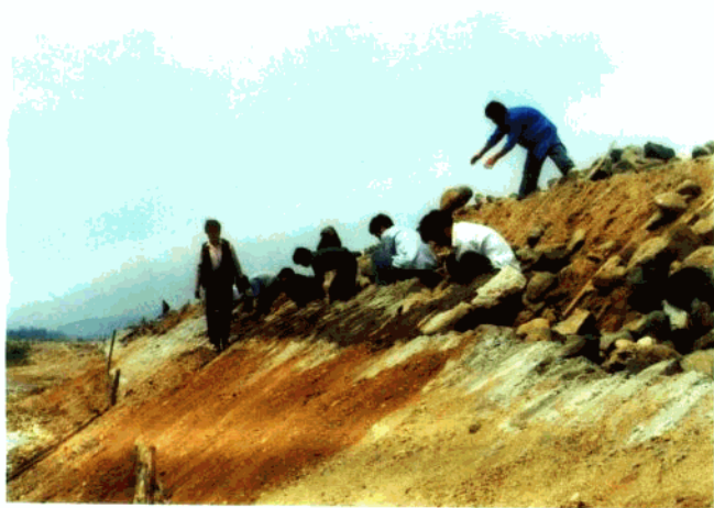
县九届人大四次会议代表提出“洛河滩涂治理”议案后，政府部门立即组织实施，图为洛河大坝火炎段施工现场
