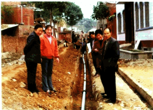
城关镇北关村石桥代表小组在视察北关村自来水管道及施工情况
