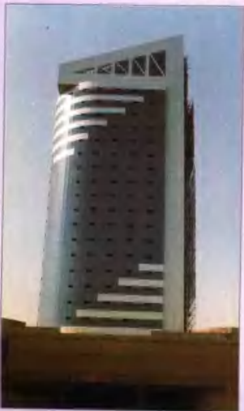
正在建设中的洛阳财会培训中心大楼
