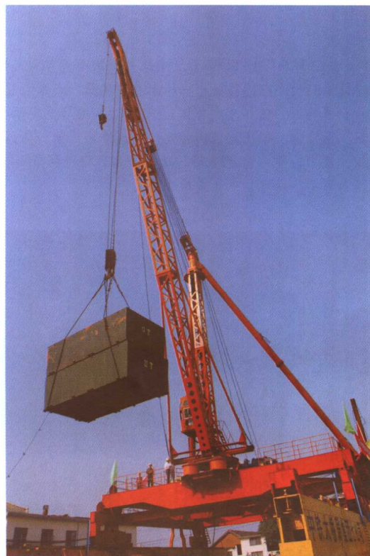
2004年5月21日，国内首台大吨位拱形爬坡架梁吊机在九江向评审专家展示各种特殊技能。中铁大桥局集团七公司研制的BWQ-35型拱形爬坡架梁吊机是为万宜铁路万州长江大桥建设而研制。该吊机由上部起重部分和下部变坡与走行部分组成，可在钢梁平直段和主跨拱曲线段行走，在0度至70度的不同坡度上进行吊装，改变了传统的拱桁架梁方式，大大提高了此类铁路钢梁的架设效率。
