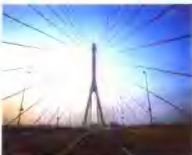
杨浦大桥有 200 根斜拉索，呈钻石形塔，高 208 米。
