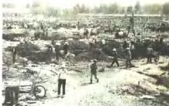
• 一九七六年七月十六日，营口化纤工程破土动工。图为土建工程一角。
