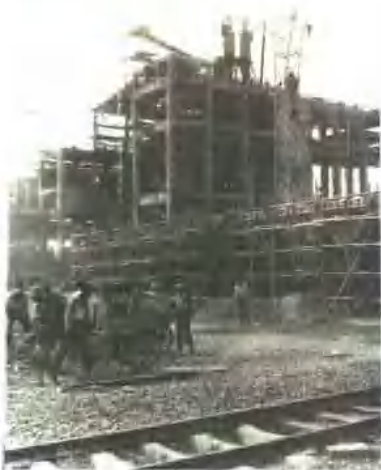
→ 图为厂区建筑一个画面。摄于一九八〇年八月。
