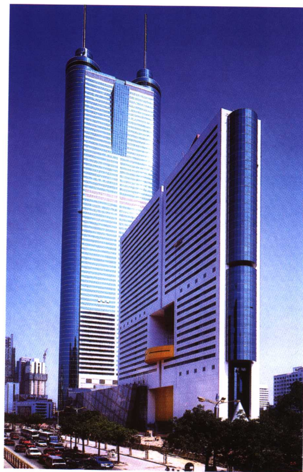
(39) 深圳地王大厦（商业综合体）
