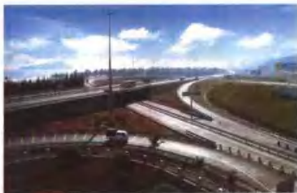
深汕高速公路的鲘门立交
