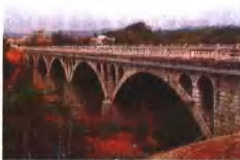
省道 335 线的上坝大桥
