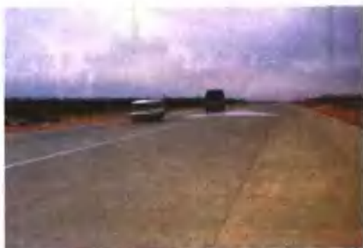
省道 338 线内南碣一级公路
