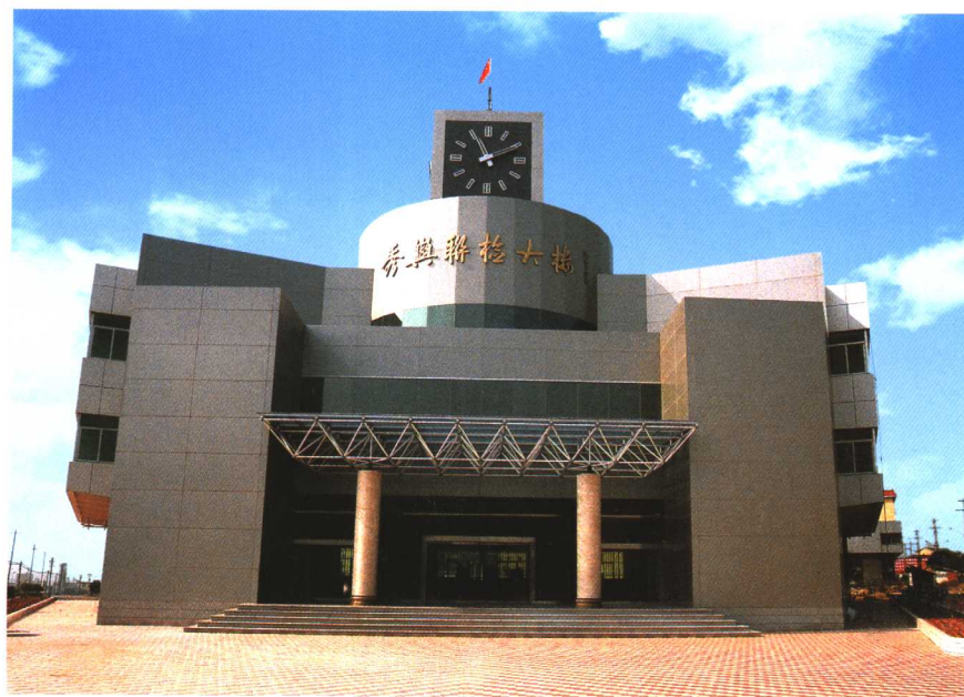
秀屿联检大楼
