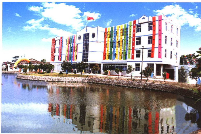
高新电子技术园区
