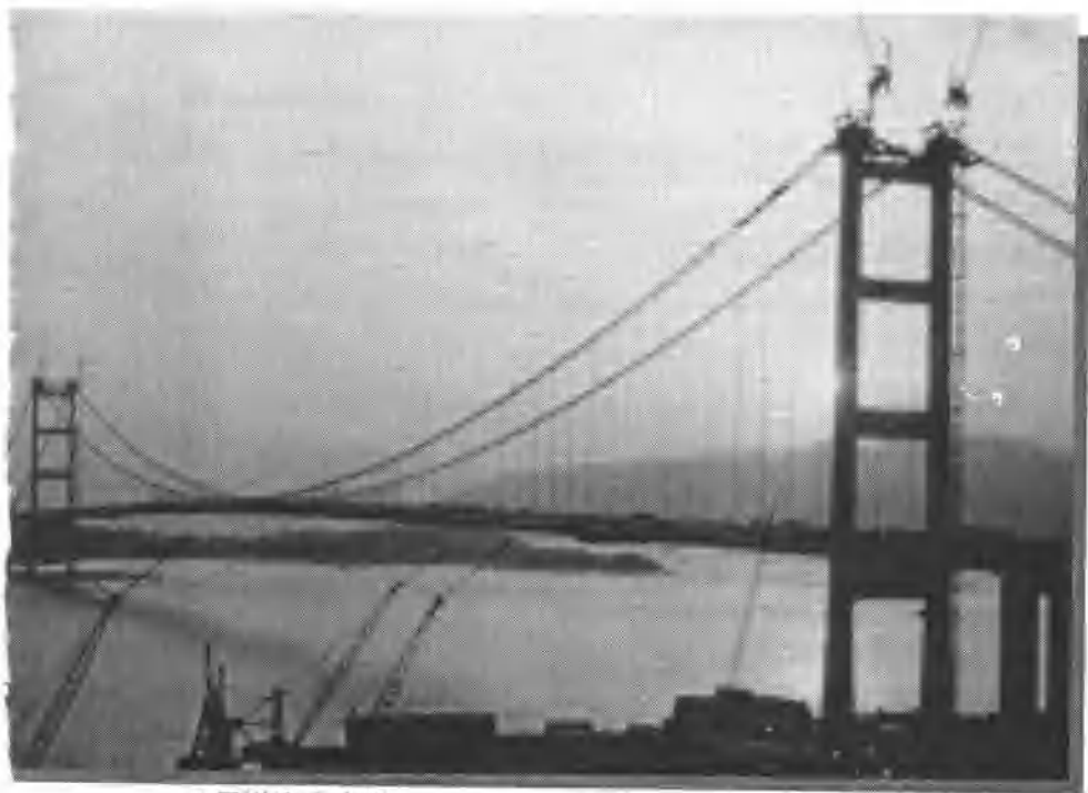
▲香港青衣大橋
