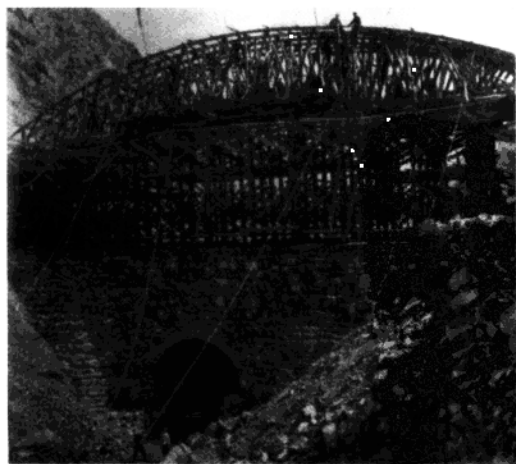
正在施工中的群英渡槽
