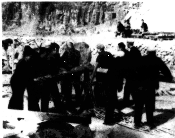
隧道天井旁的土绞磨
