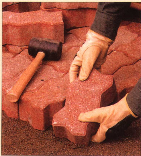
互锁铺装物。 用各种颜色、形状且耐用的混凝土制成，这类铺装既有装饰效果又易于铺砌。
