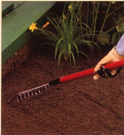
房子周边平整。 在屋基周围平整土地，用表土更换侵蚀土壤，在屋基周围耙平，坡度应从屋基向外微倾
