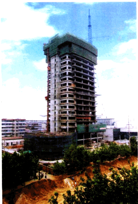
正在建设中的市广电大楼
