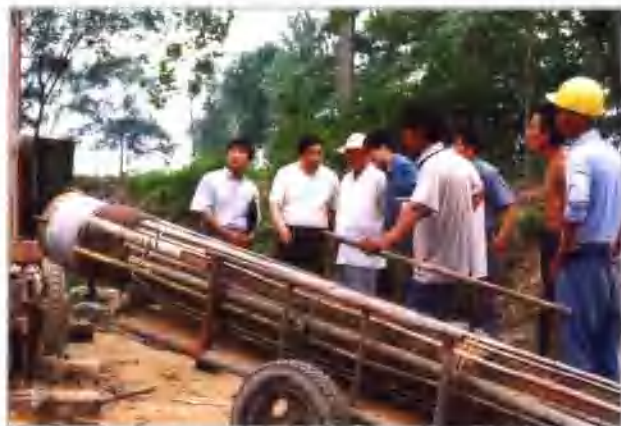
局长马治国在打井工地
