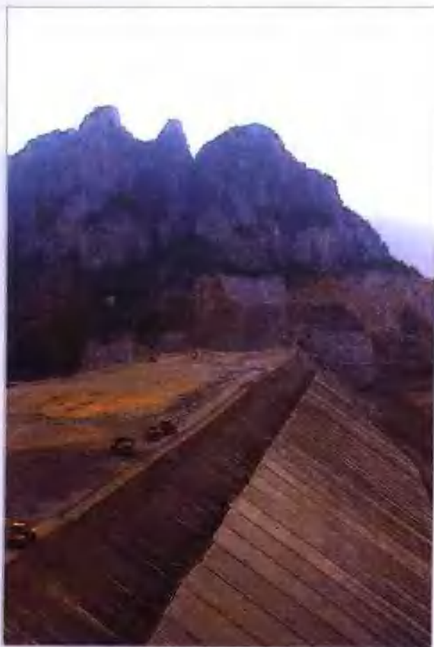
建设中的盘石头水库
