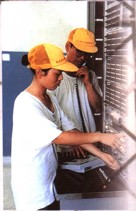
电化局青年突击队在蕪春通信站施工
