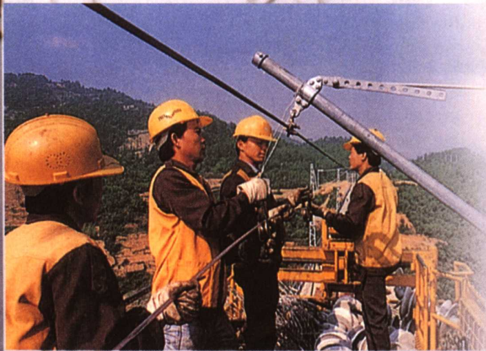
在南昆线上架设接触网导线
