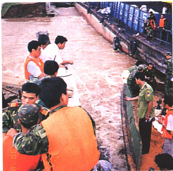
● 图为1998年长江大堤九江段决口处。
